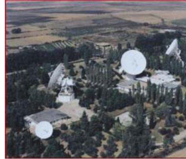
Δορυφορικός Σταθμός Θερμοπυλών
